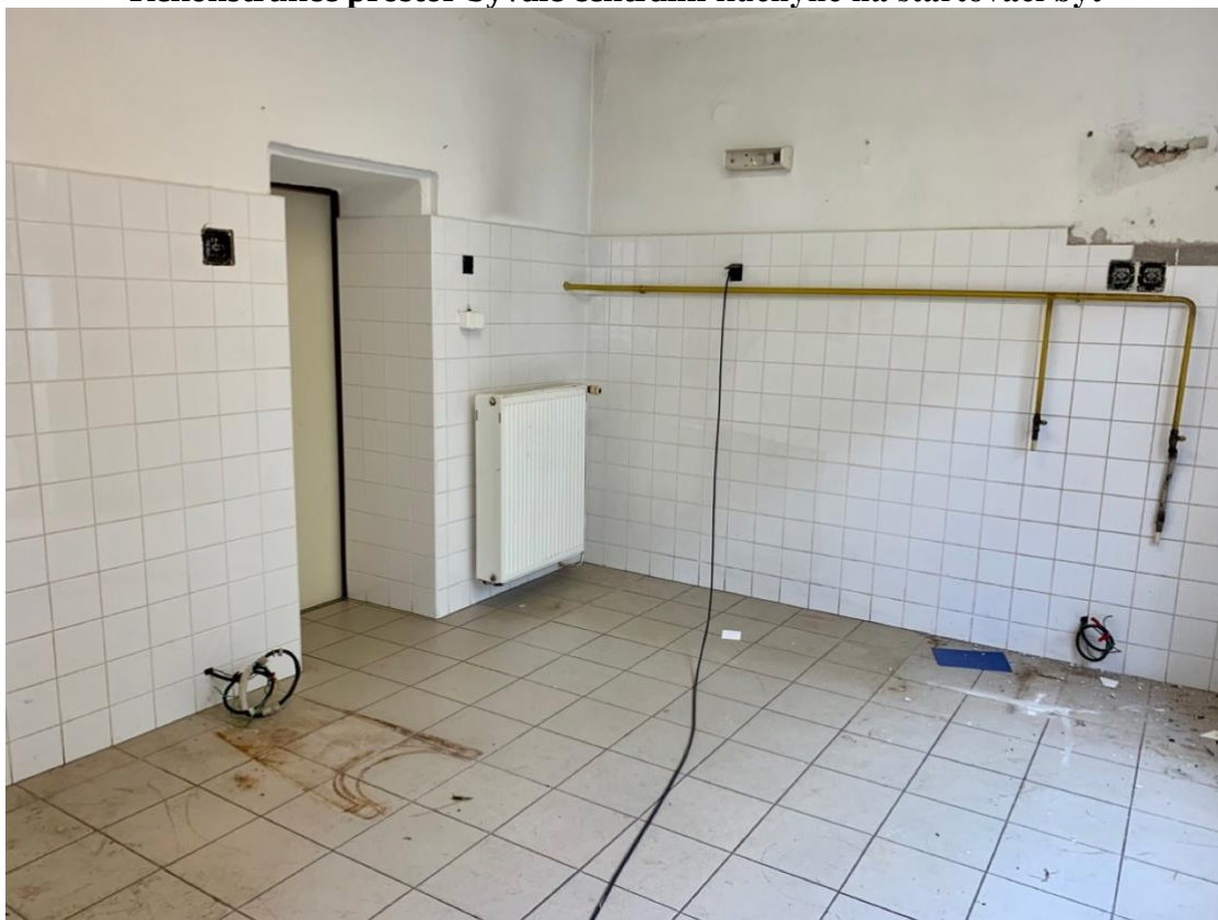
Rekonstrukce prostor bývalé centrální kuchyně na startovací byt
